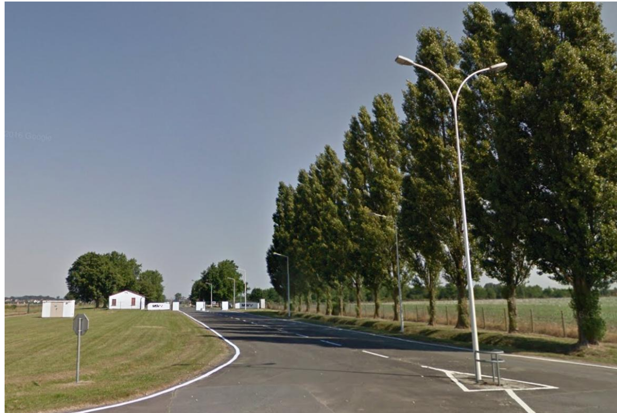
Accès existant depuis la RD54
